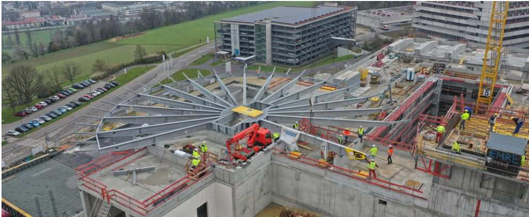
Foto der Fa. Stahlbau Süssen
